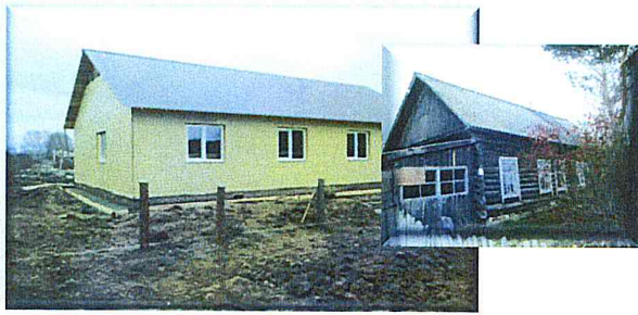
Строящийся дом взамен аварийного в с. Авяк Знаменского района
