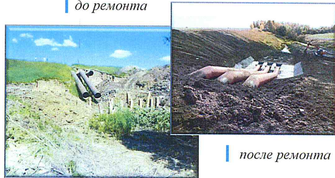
Гидротехническое сооружение на реке Бызовка у с. Такмык Большереченского района до ремонта
