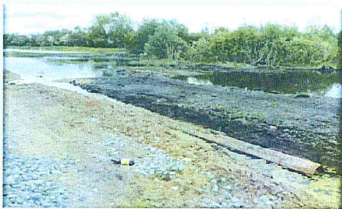
Укладка водопропускных труб, г.Тара, ул. Чкалова
