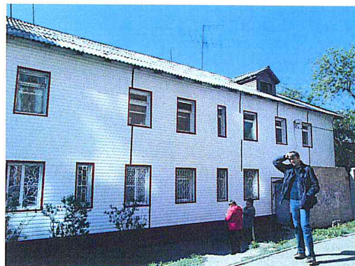
Ремонт фасада многоквартирного дома в городе Омске
